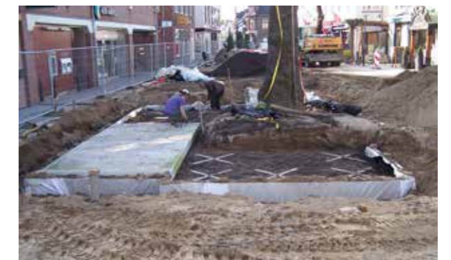
Groeiplaatsverbetering om de vitaliteit van een boom in de stad te vergroten. (Bron: Nationale bomenbank)
