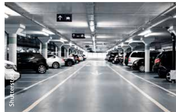
Georganiseerd parkeren in parkeergarages en optimale bezetting van ruimte.
